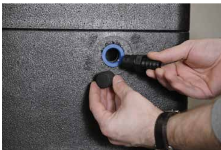
Tilslutning af kondensafløb
